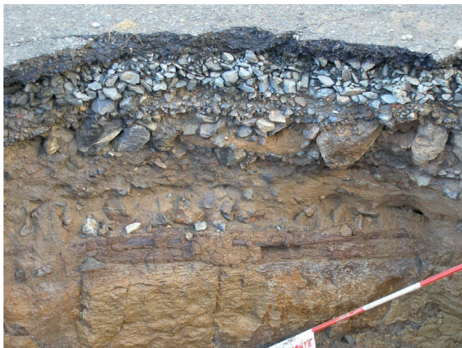
Obr. 6. Blovice, Bělohrobského ulice, výkop před tzv. starou školou č.p. 88. Dřevěné vodovodní potrubí na J profilu dokumentovaného úseku, foto J. Bouda 2011.
