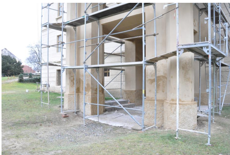
Oprava havarijního stavu terasy východního křídla zámku Hradiště, 2021
