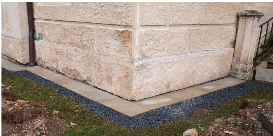
Instalace okapového chodníku kolem západního křídla zámku Hradiště, 2021
