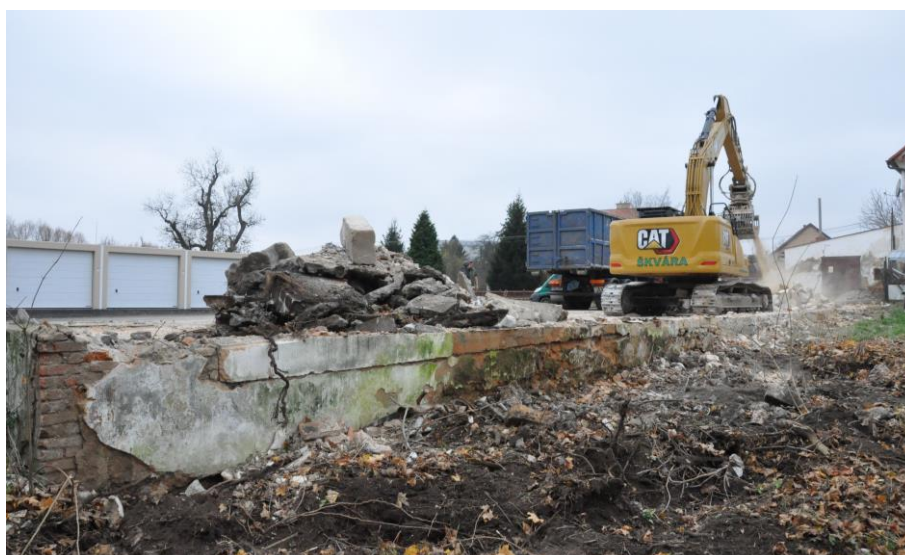
Bourání garáží v areálu bývalého zámeckého zahradnictví, 2021
