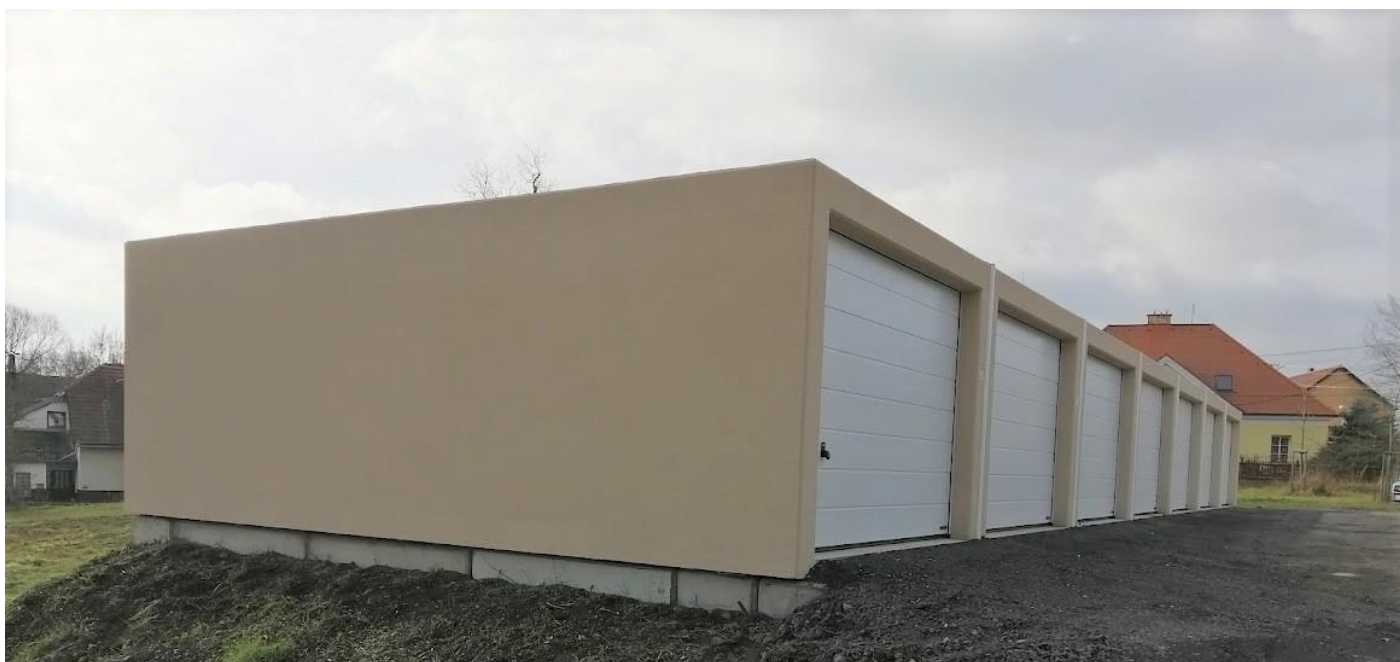
Instalace provizorních garáží v areálu bývalého zámeckého zahradnictví, 2021
