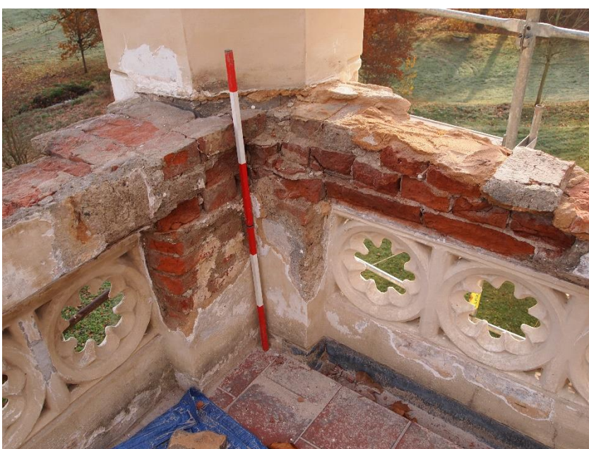
Oprava havarijního stavu terasy východního křídla zámku Hradiště, 2021
